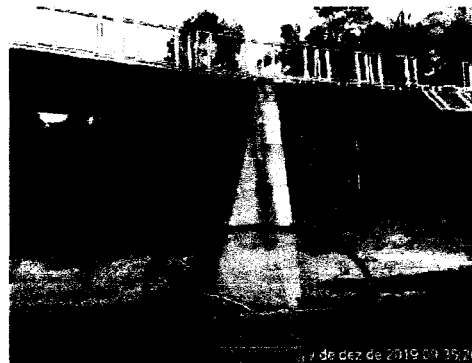
Fundação do pilar central comprometida, pilar central fora de prumo.
