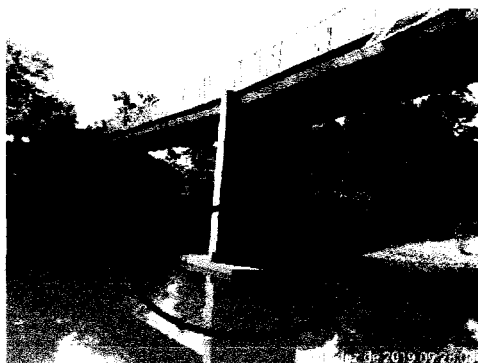
Fundação do pilar central comprometida, pilar central fora de prumo.
